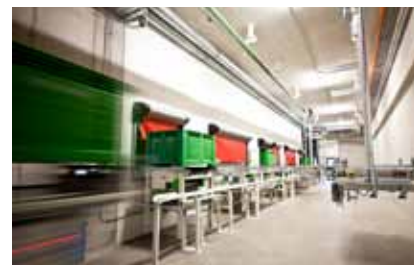
Schleusen ins Hochregallager
