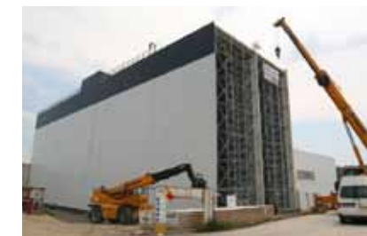
Der letzte Schliff an der Fassade
